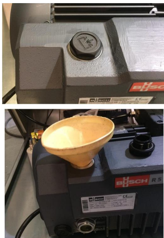
Ilustracja 7. Odkręcenie korka wlewu oleju i uzupełnianie nowego oleju
